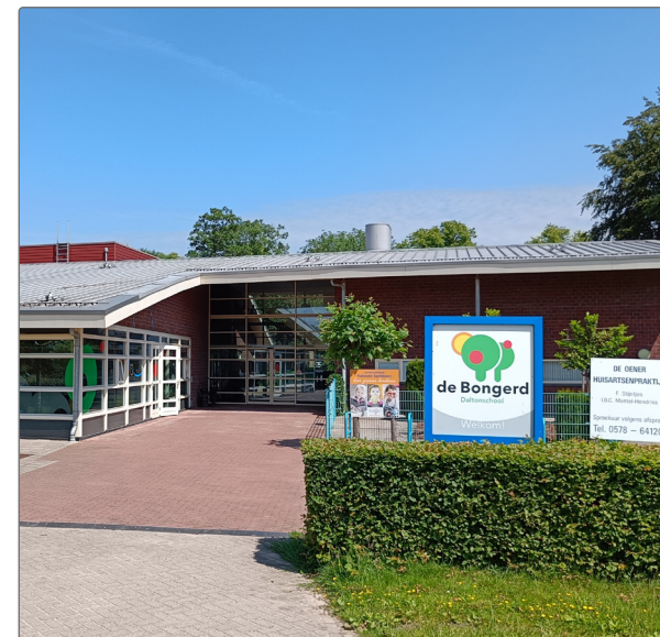
Basisschool en huisarts zijn basisvoorzieningen
