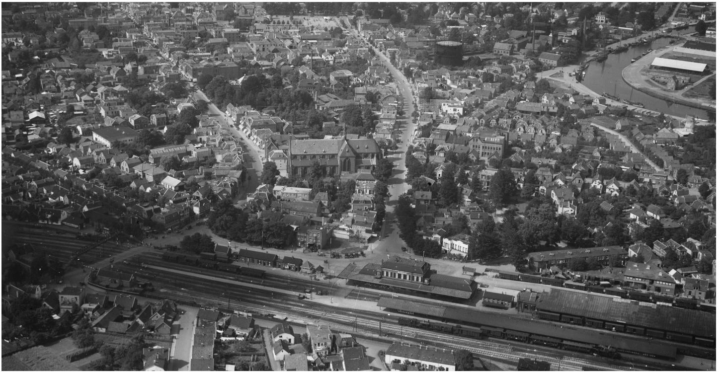
Het station en het Apeldoorns Kanaal worden in Apeldoorn dicht bij elkaar gelegd. De oude enken worden vooroorlogs als eerste volgebouwd.
