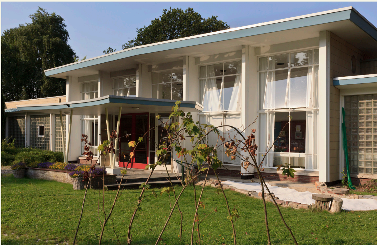
De 'Kweekschool voor kleuteronderwijzeressen' in Apeldoorn is in 2014 een Rijksmonument geworden. Het gebouw is in 1961 gebouwd.
