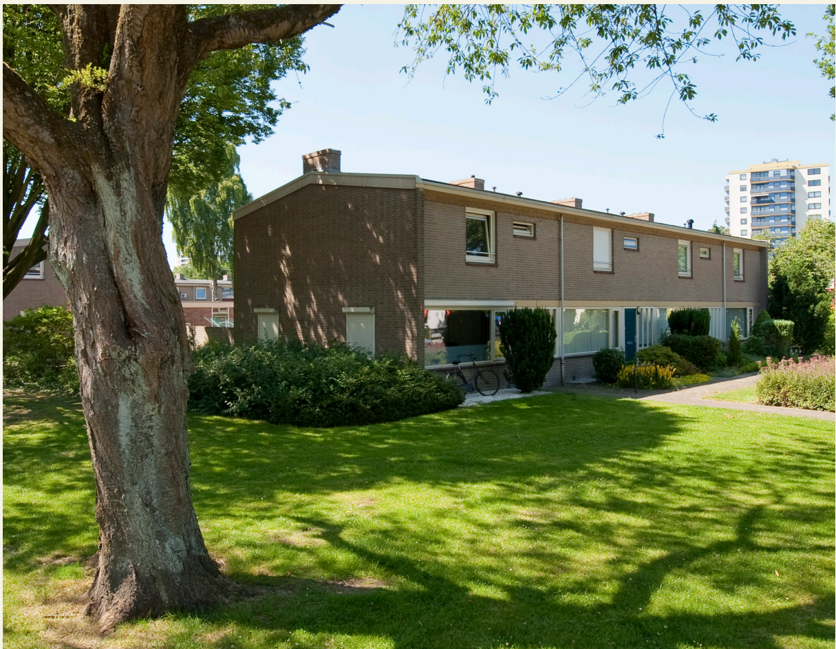
De zuidkant van de wijk Kerschoten is door de RCE in 2013 benoemd als wederopbouwgebied van nationaal belang. De wijk is tussen 1956 en 1958 gebouwd.
