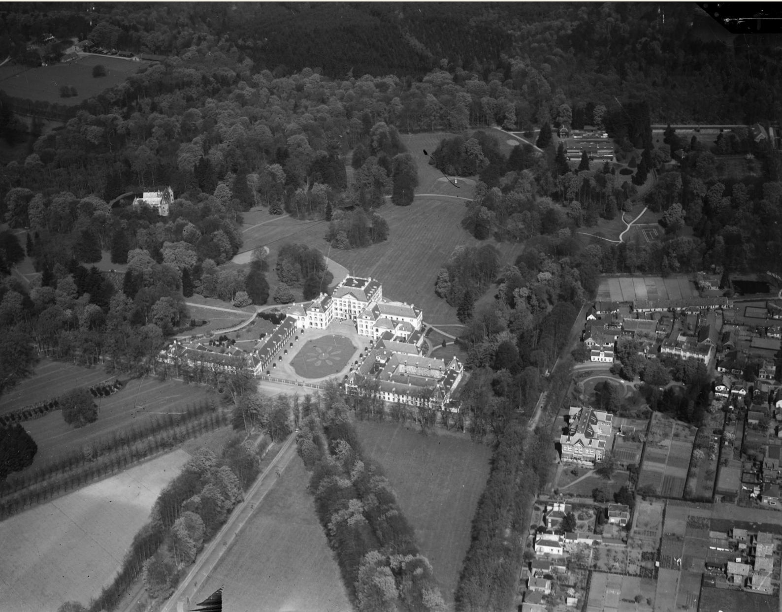
Op de vooroorlogse foto is Paleis Het Loo te zien voordat de formele tuin wordt gerestaureerd. Op de huidige, topografische kaart is de replica van de barokke stijl ingetekend die vanaf 1977 is aangelegd.
