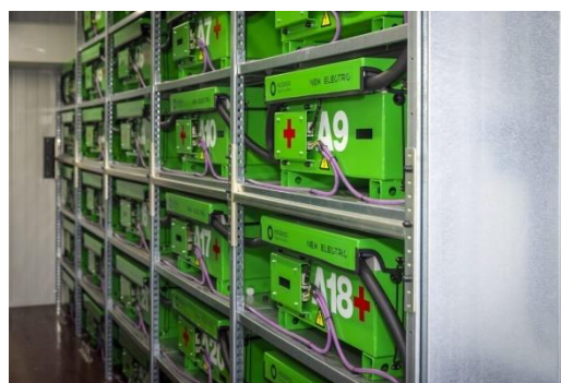
Accu's van Hedgehog bij De Rooy. De accu's van de eerste elektrische truck van De Rooy hebben een tweede leven gekregen – Foto: Marleen Stoker/ Moker Media
