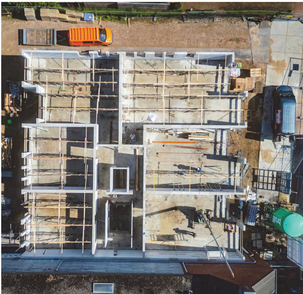
Woningbouw Twello, Voorst
