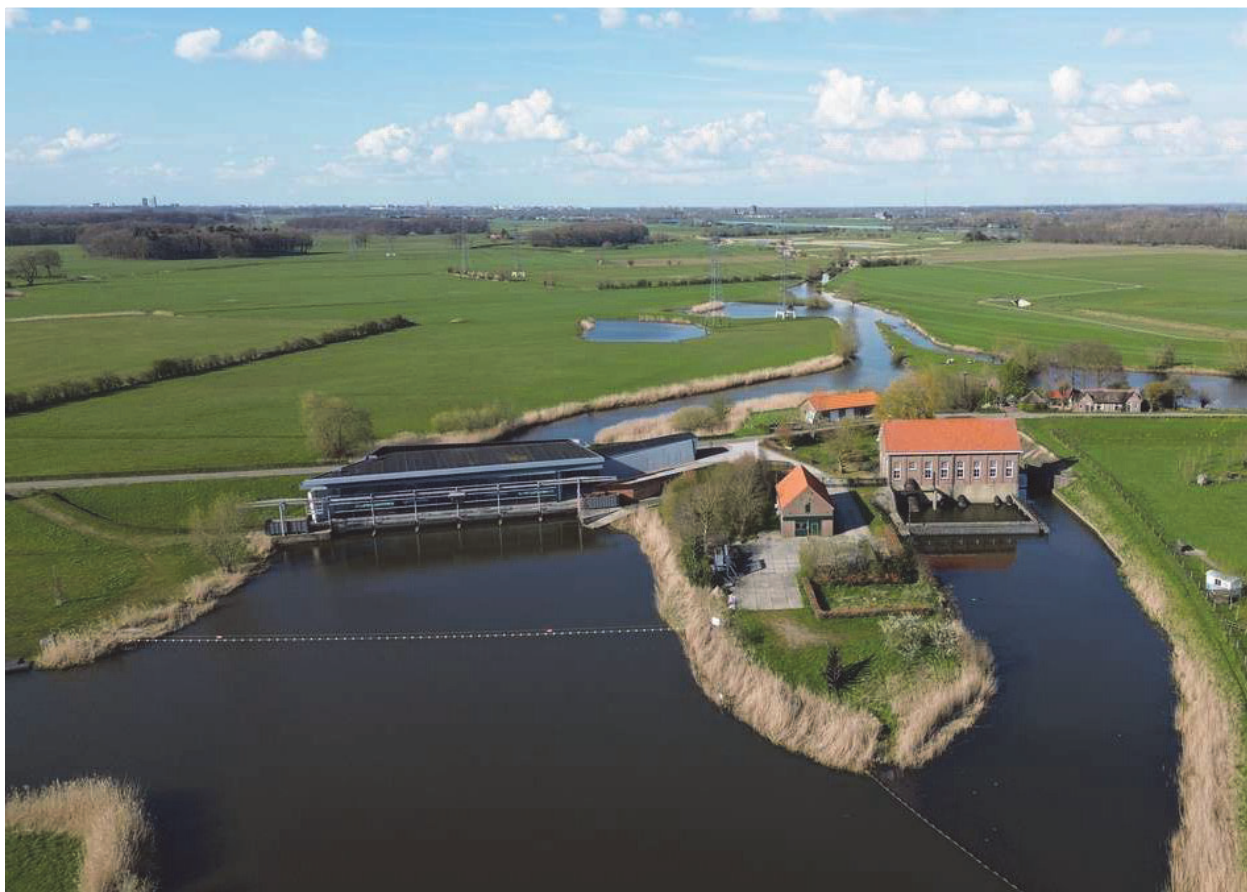
Gemaal in Werven, Heerde
