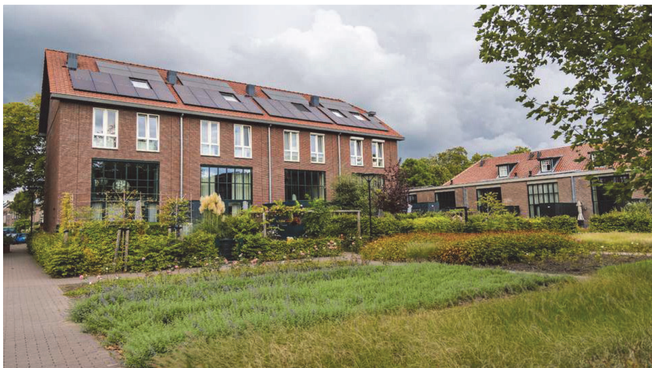
Zonnepanelen, Nieuw Larenstein, Deventer
